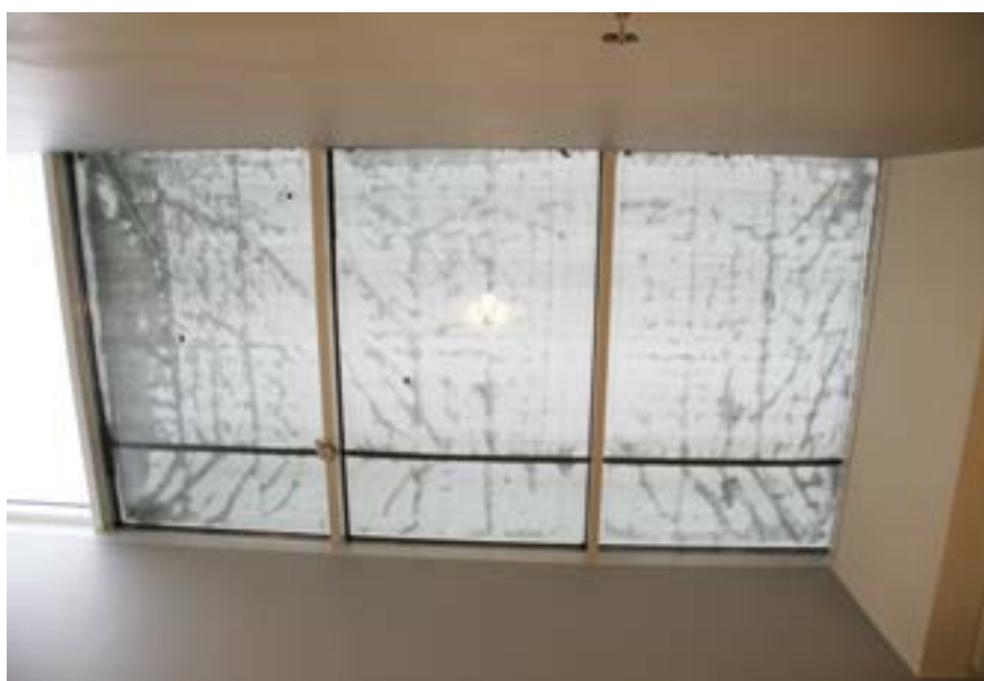
En presenning hindrar nu läckaget. Husets ägare skulle allra helst ta bort takfönstren och lägga dit plåt i stället.
